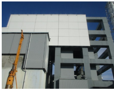
4号機 燃料取り出し用カバー
